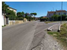
12_incrocio tra Via Rossa e Via Cavallinone
